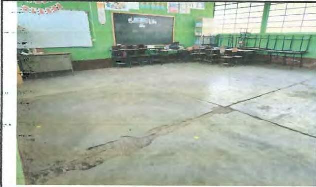
Foto1: Se realizará instalación de piso adentro de aula.
