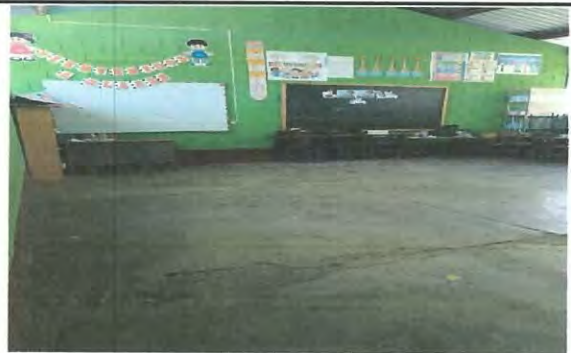
Foto 6: Se realizará instalación de piso adentro de aula.
