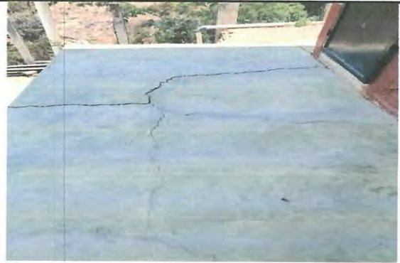
Foto 2: Se realizará instalación de piso en el corredor de la escuela.
