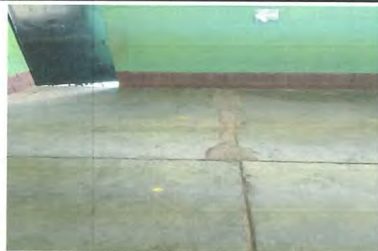
Foto 4: Se realizará instalación de piso adentro de aula.
