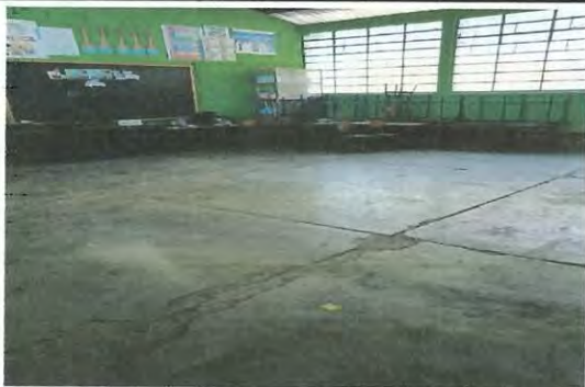
Foto 5: Se realizará instalación de piso adentro de aula.
