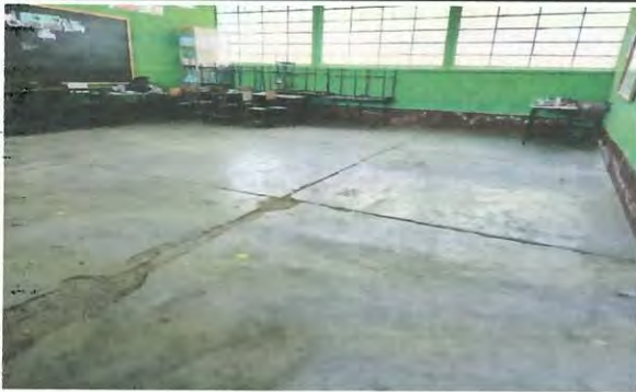
Foto 3: Se realizará instalación de piso adentro de aula.
